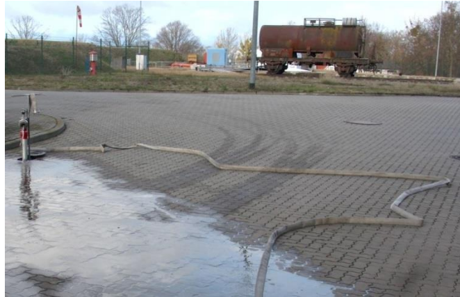
Abbildung 9: Wasserversorgung zur Schaumerzeugung
